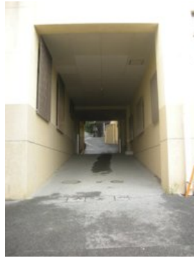
西館下のトンネル
