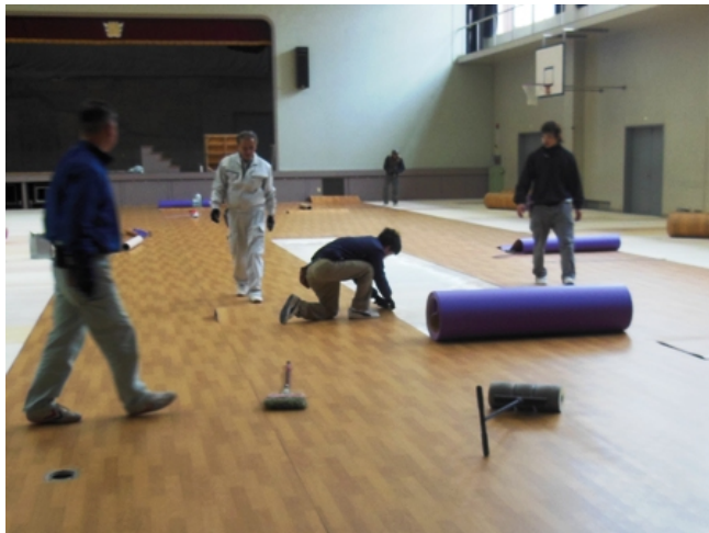
講堂では床の張り替え作業が急ピッチ！ おそらく午後は…私も急ピッチ ……………
