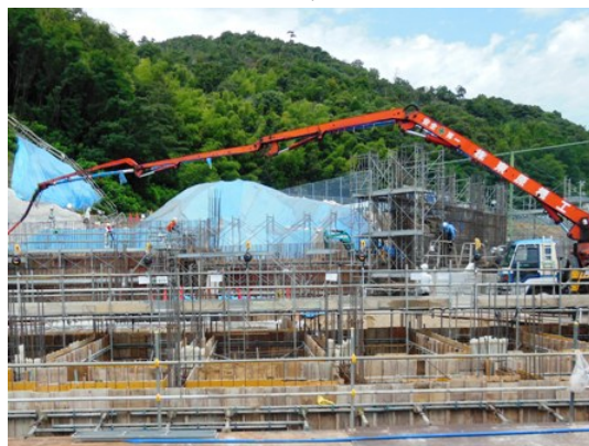
コンクリートポンプ車を經由…生コンを遠方に流し込んでいます。
