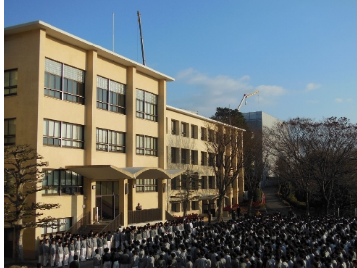
校舎の後ろでは、2機のクレーンが忙しく動いています…
